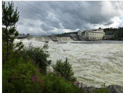
Rånåsfoss kraftverk Foto: NVE, Arne T. Hamarsland
